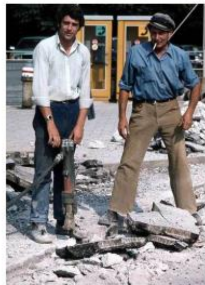
Türkische Arbeiter im Straßenbau, vermutlich 1972.
